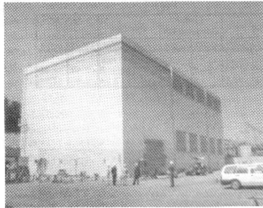
图 3 截至 2001 年在东海-2 核电厂建造中的干式金属罐贮存设施
